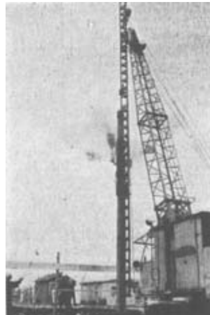
Unerbittlich Pfahlbau im Schwemmland
